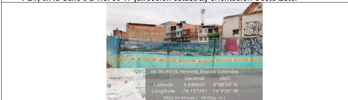
Foto No. 2 – Vista panorámica del predio orientación Oeste-Este.
